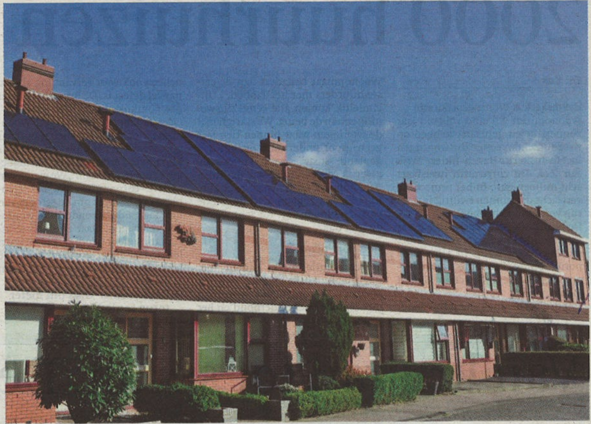
Zonnepanelen op woningen aan de Besloten acker in Heemskerk.
