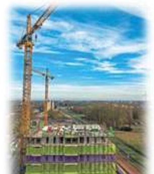
De Slotvrouw Heemskerk in aanbouw (221 woningen)
