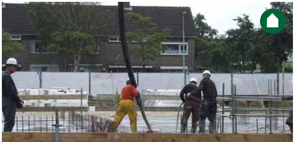
Foto van het beton storten via een enorme slang (foto: WOONopMAAT)
