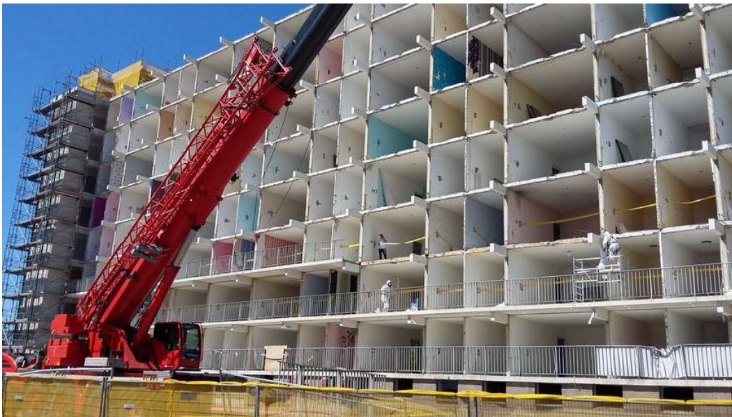
Sloop 192 appartementen Debora Bakelaan Heemskerk voor 201 sociale huurappartementen en 21 koopwoningen, De Slotvrouw.
