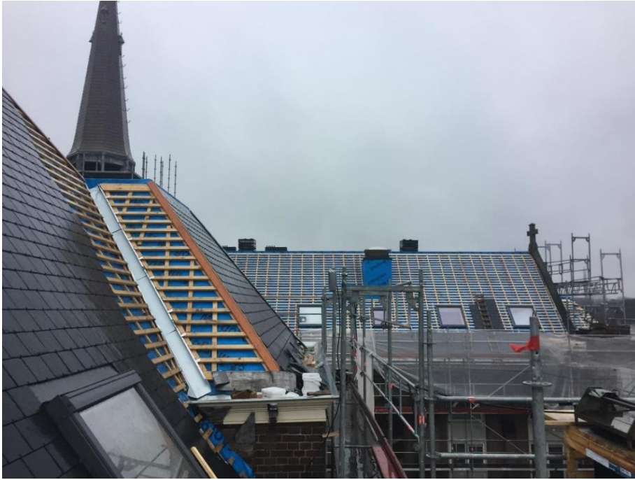
Renovatie monumentaal appartementencomplex de Kweekschool in Beverwijk.
