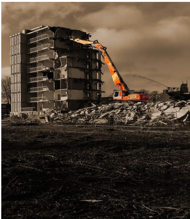
Sloopwerk Rode flat
