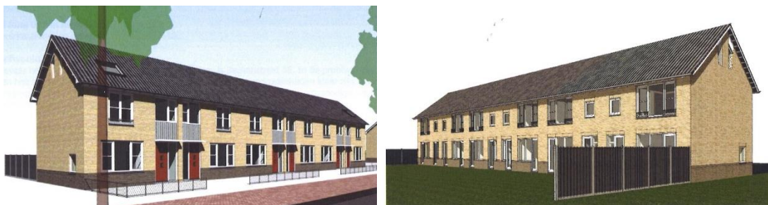
Voorgevel en achtergevel Beukenstraat, renovatie pilot duurzaam voorraadvat, uitbouw en PV-zonnepanelen
