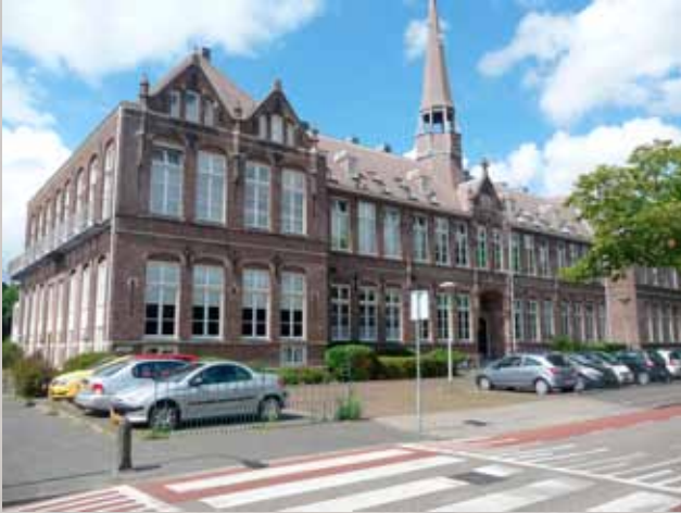
Baanstraat, Beverwijk; nieuwe cv-ketels plaatsen en dakafwerking vervangen.
