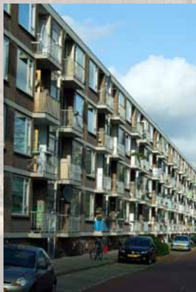
Beneluxlaan, Heemskerk; betononderzoek.
