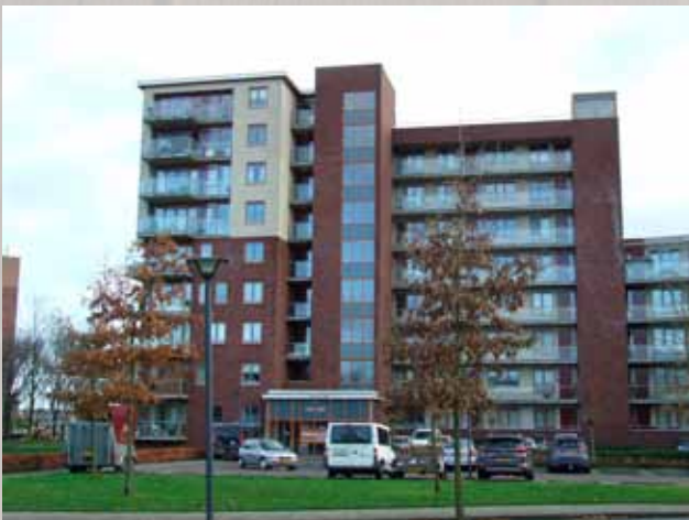
Lessestraat, Heemskerk; ventilatieonderzoek.
