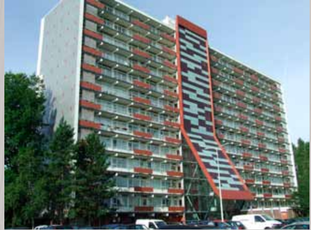
Luxemburglaan Heemskerk; schilderwerk, plaatsen nieuwe hekwerken en radiator- en watermeters.
