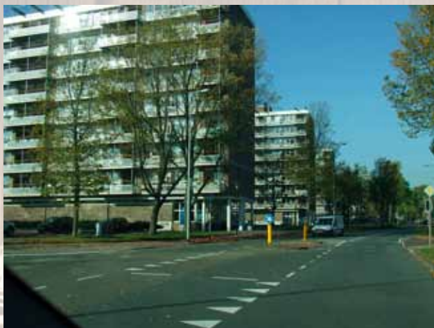
Uiverhof, Plesmanweg en Pelikaanhof, Beverwijk; vervangen kozijnen.
