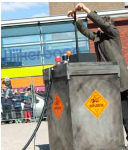
Start sloop Torenflat, 2 april 2013
