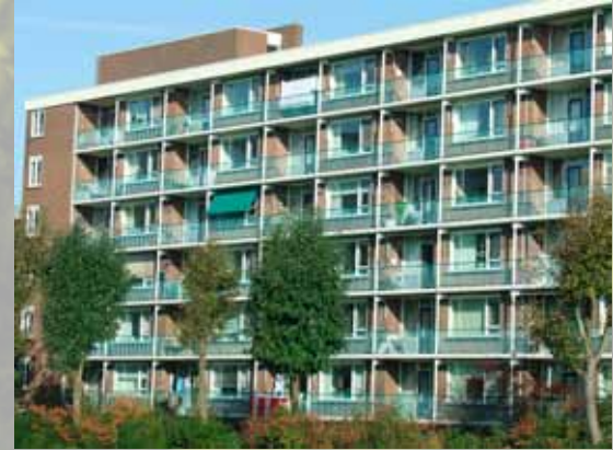
Schilderwerk Dellaertlaan , Beverwijk
