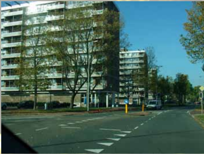
Gevelonderhoud Wijkerbaan, Beverwijk
