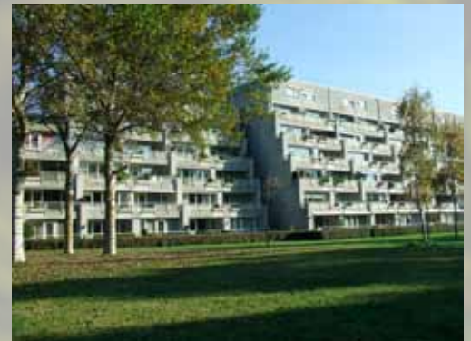
Drinkwater- en cv-installatie aanpassen Laan de Nederlanden, Beverwijk
