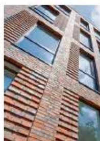
RITMIEK IN DE GEVEL, DETAIL IN METSELWERK
