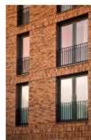
NEGGE EN AFSTEMMEN KLEUR BALKONHEK
