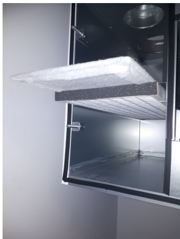
Figuur 27 Plaatsing van het filter in de ClimateControl
