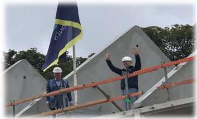
Nieuwbouw 40 duurzame eengezinswoningen Kingsford Smitstraat Beverwijk
